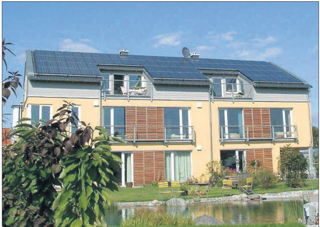
Schutz, der Energie erzeugt: Mit ihren 92 Modulen schirmt die PV-Anlage die Dachhaut fast komplett ab und hebt die Lebensdauer des Dachaufbaus, indem sie die Verwitterung verlangsamt. Foto: nh
