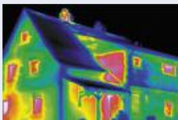
Die Thermographie zeigt, wo unnötig Wärme entweicht.
