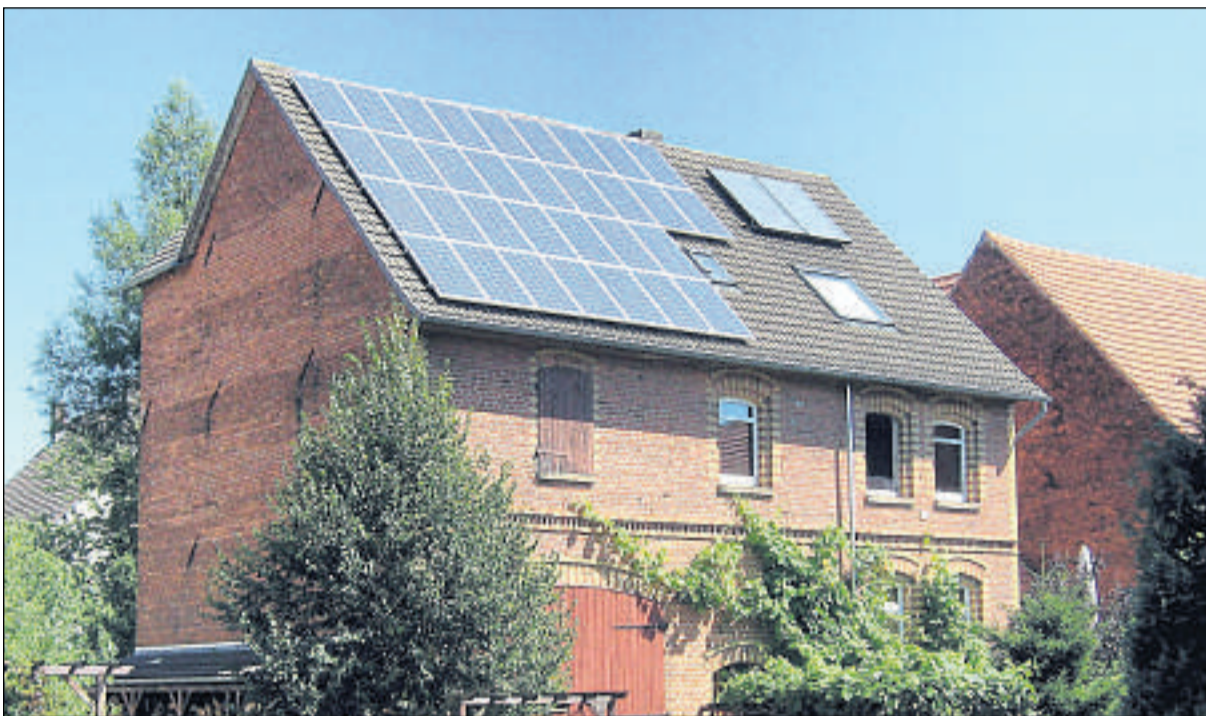
Schnell erledigt: Innerhalb von zwei Tagen lässt sich eine sechs kWp-Anlage zur Solarstrom-Produktion fachgerecht installieren. An diesem Haus hat ÖkoTronik 32 Solarmodule verbaut.
